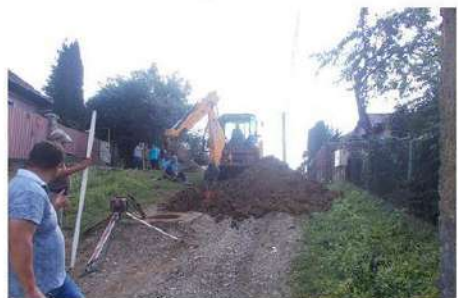
S-a prelungit rețeaua de canalizare pe strada Lutului
