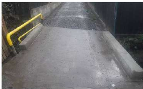
Au fost reconstruite mai multe poduri din comună
