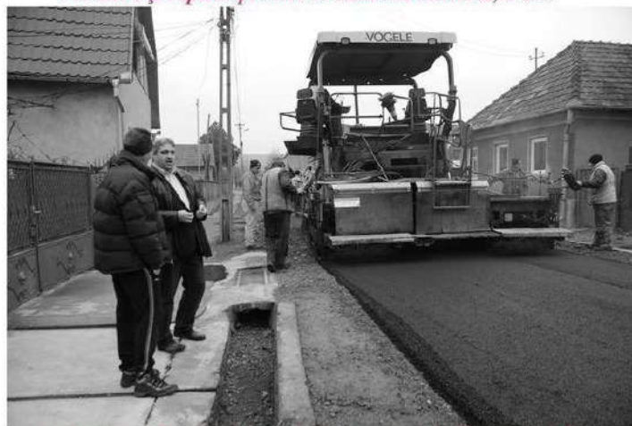
Terminarea lucrărilor de asfaltare pe strada Bisericii, 23 dec.
